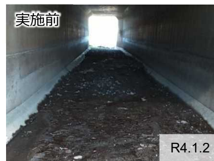
樋門内の堆積土砂撤去前後
