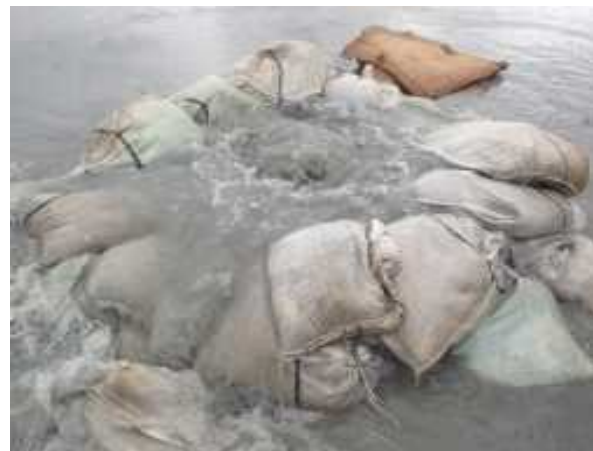
平成29年台風21号出水による噴砂の状況（木津川右岸6.0k付近）
