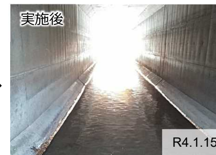
樋門内の堆積土砂撤去前後
