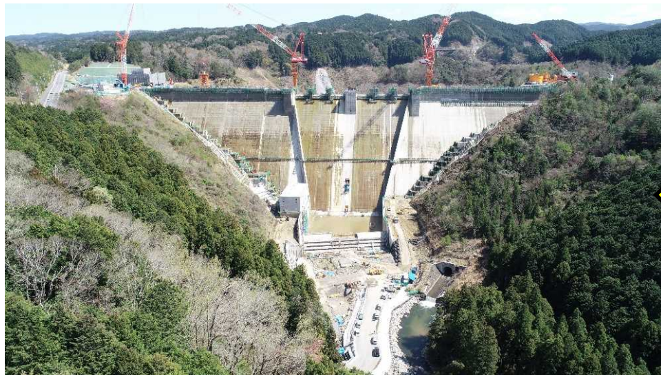
令和3年4月：ダム堤体打設完了
