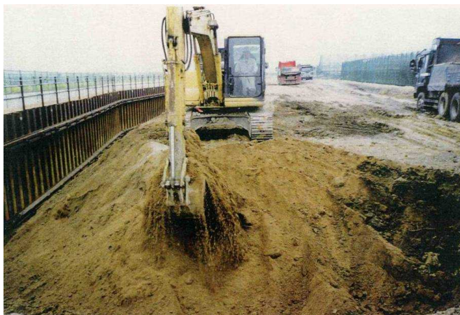
砂でできた脆弱な堤防（木津川）
