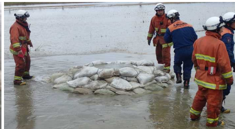
平成29年台風21号出水による噴砂の状況（木津川右岸6.0k付近）
