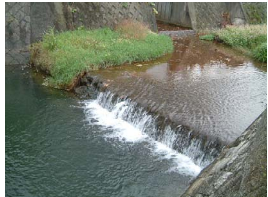
写真 4.2.3-9 瀬田川 流入支川合流部
