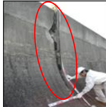
特殊堤の変状
