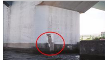
淀川大堰堰柱コンクリートの剥離
