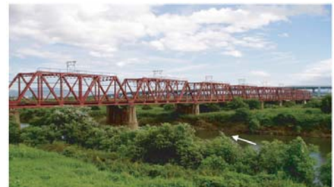
写真 3.6-2 河道内樹木の繁茂状況(木津川)
