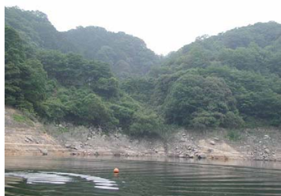
写真 3.2.7-3 貯水池斜面の裸地
