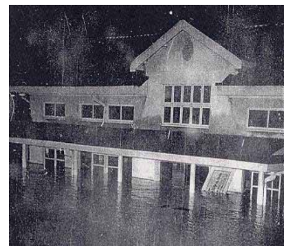
写真 3.3.1-4 亀岡駅 (昭和28年9月台風13号)
