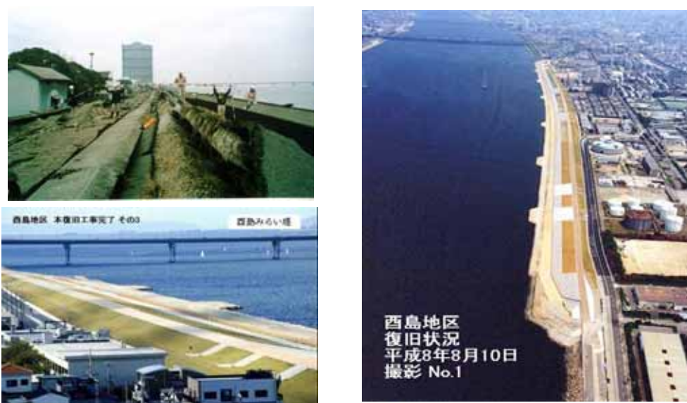
写真 3.3.3-1 西島地区災害復旧工事状況
