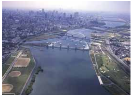
写真 3.2.3-1 淀川大堰から下流を望む
