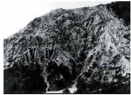
写真 3.3.1-12 三上山の荒廃状況（大正4年）
