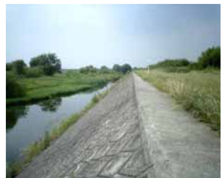
写真 3.2.7-1 コンクリート護岸
