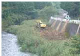
土砂置土整地状況
