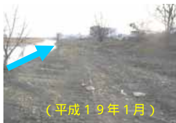
写真 4.2-6 試験施工実施前
