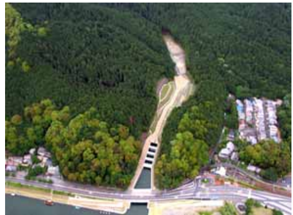
写真 4.3.3-6 大津放水路(瀬田川合流部)
