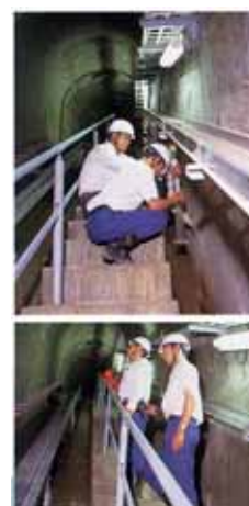
ダム本体の観測・点検状況
