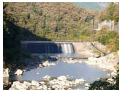
写真4.2-12大河原発電所井堰（木津川）
