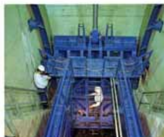
ゲートの点検状況
