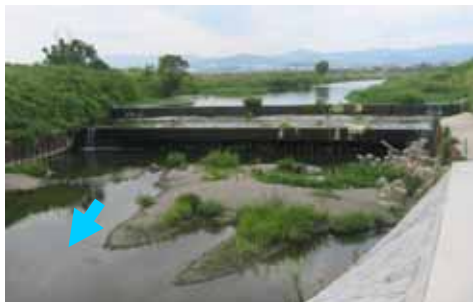
写真 4.2-8 縦断方向の河川形状の修復（芥川 1号井堰）
