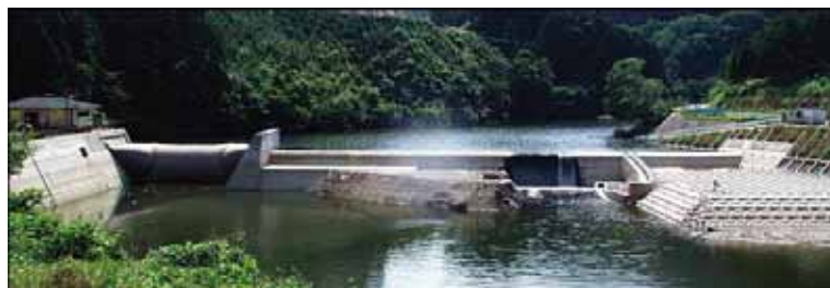
写真 4.2.4-4 副ダム (室生ダム)
