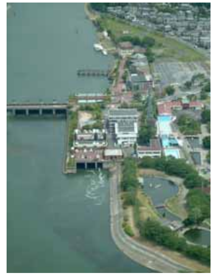
写真 4.3.3-3 瀬田川洗堰のバイパス水路
