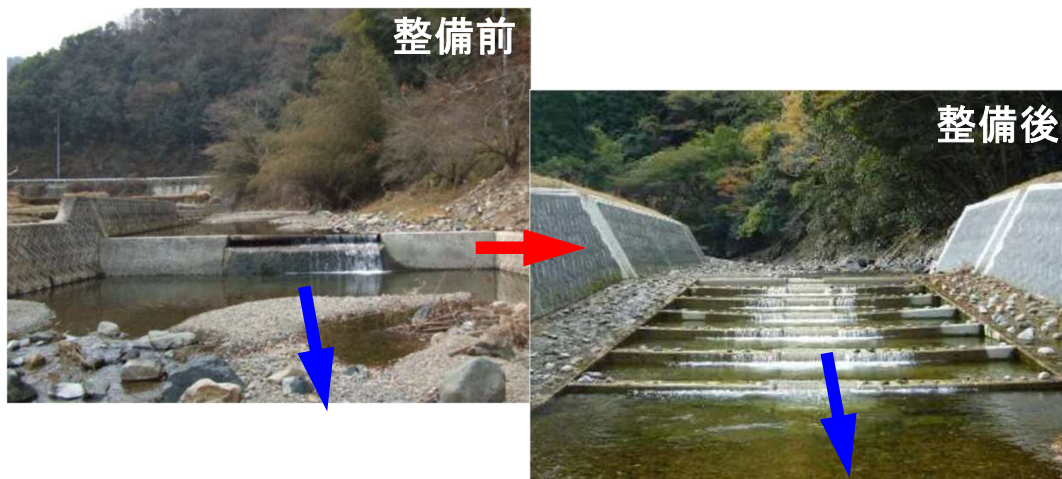
堰の撤去 (二)大日山川(佐用町)
