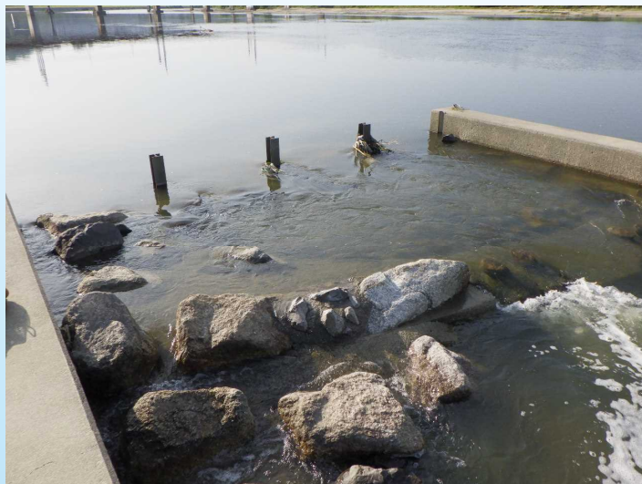
柏原堰堤右岸魚道
