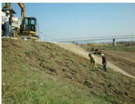
覆土施行状況（土の攪乱を最小限にする）
