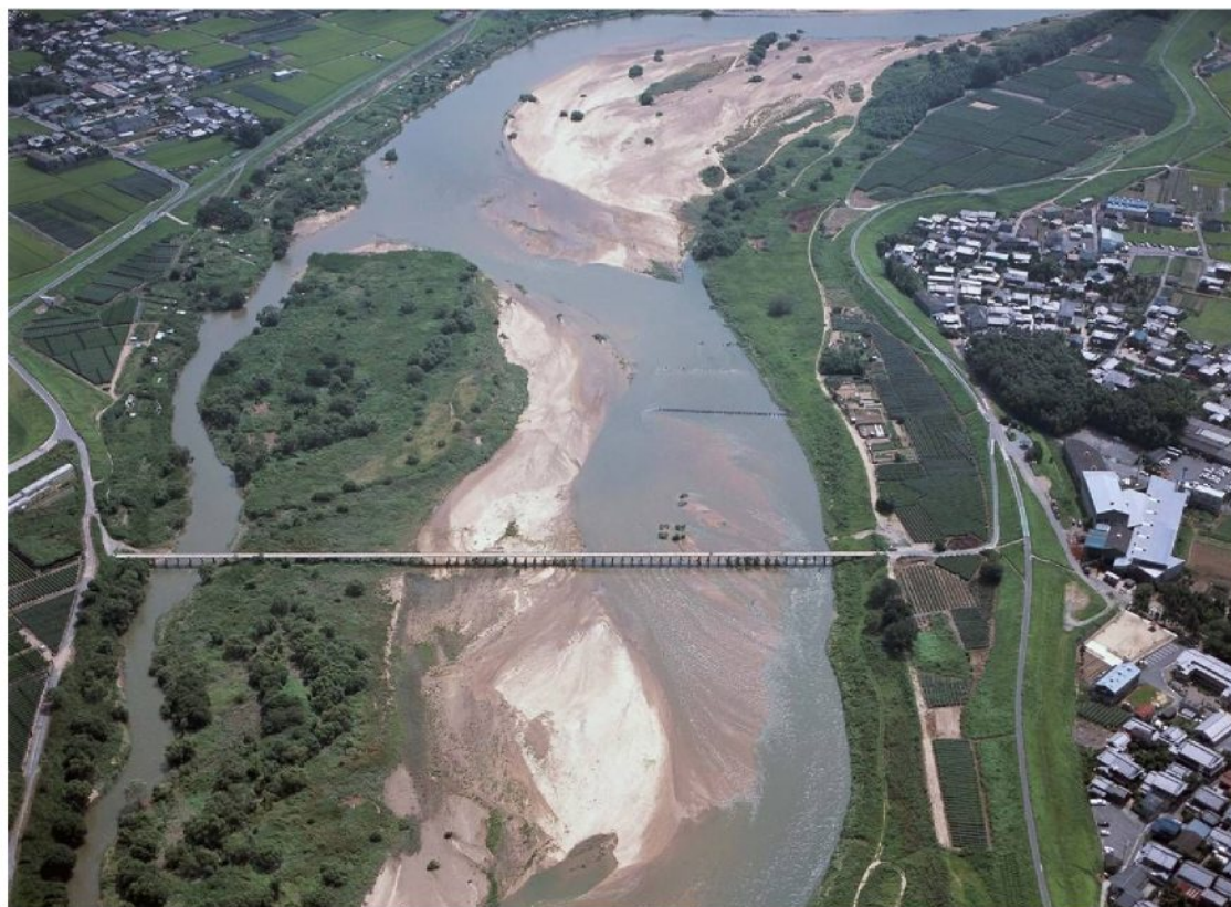
航空写真（木津川6. OK付近）
