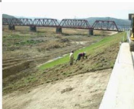
覆土施行状況（土の攪乱を最小限にする）
