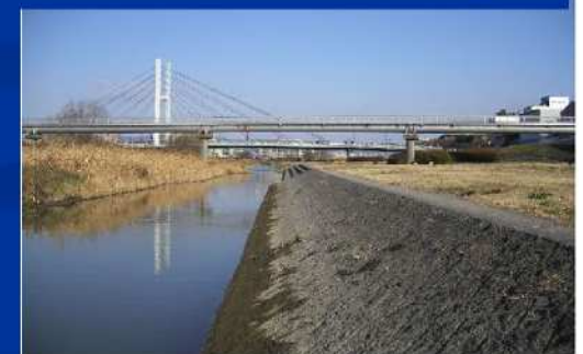
低水護岸整備に伴う水陸移行帯の消失
