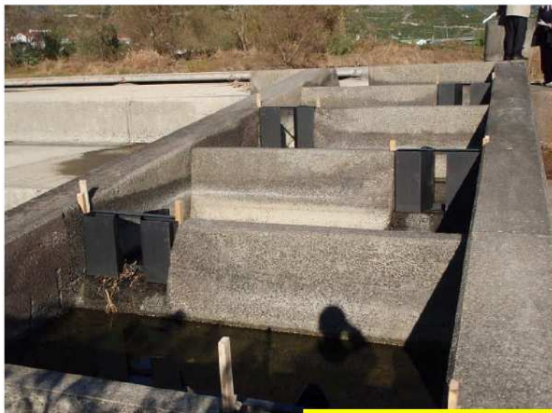
簡易バーチカルスロット隔壁の設置状況(通水前／通水後)
