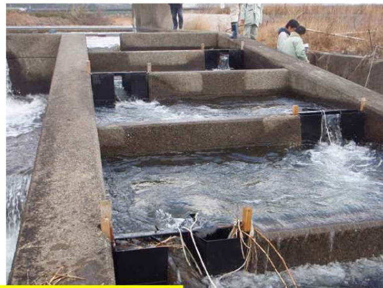
簡易バーチカルスロット隔壁の設置状況(通水前／通水後)
