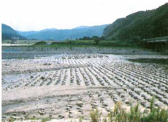
粗石付斜曲面型 斜曲面・斜路(前段面)
