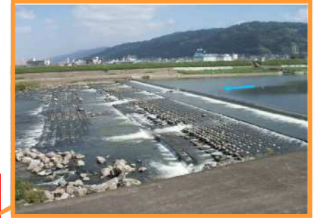
柏原堰堤左岸側
