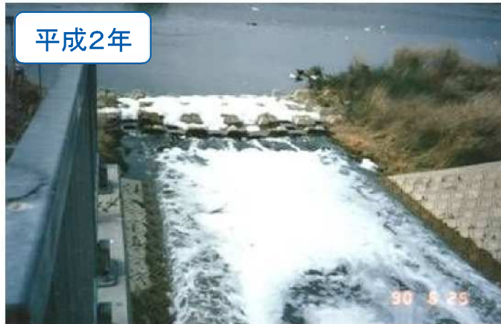
流入支川から汚濁水の流入
