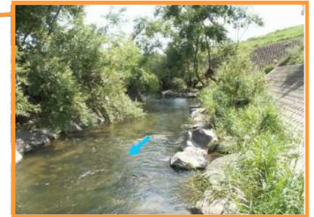
柏原堰堤下流左岸せせらぎ水路
