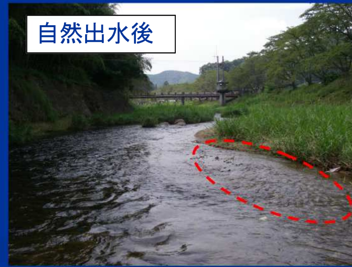
布目ダム下流における河床形状の変化の例(平成19年度) (土砂供給地点より約5.5km下流地点)
