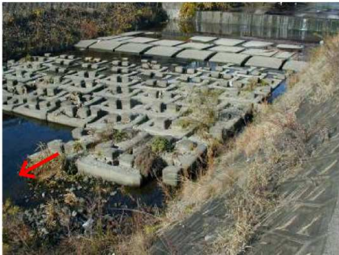
水位低下、落差工の存在 による魚類等の遡上阻害
