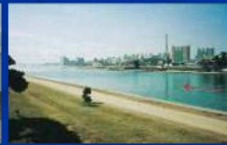
南部橋(河口から1.9k付近)
