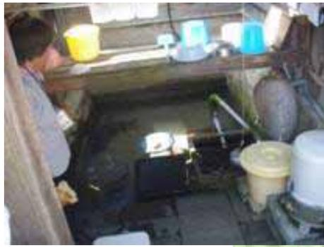
湧出した水を生活用水として利用した後、鯉等に残飯処理させ水路へ流し、最終的にきれいな水を琵琶湖へ返すシステム。
