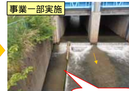
魚道一部実施 (H24完成予定)
