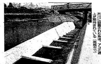
高槻市を流れる芥川、約3キロ上流にあり、階段状に、国交省が約2キロに水を流れて存在を多客差を解消する魚道を設置するよう計画している。このため、芥川の合流点から下流
