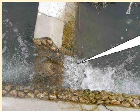
流れが剥離している状態。空隙が生じて白くなっている。
