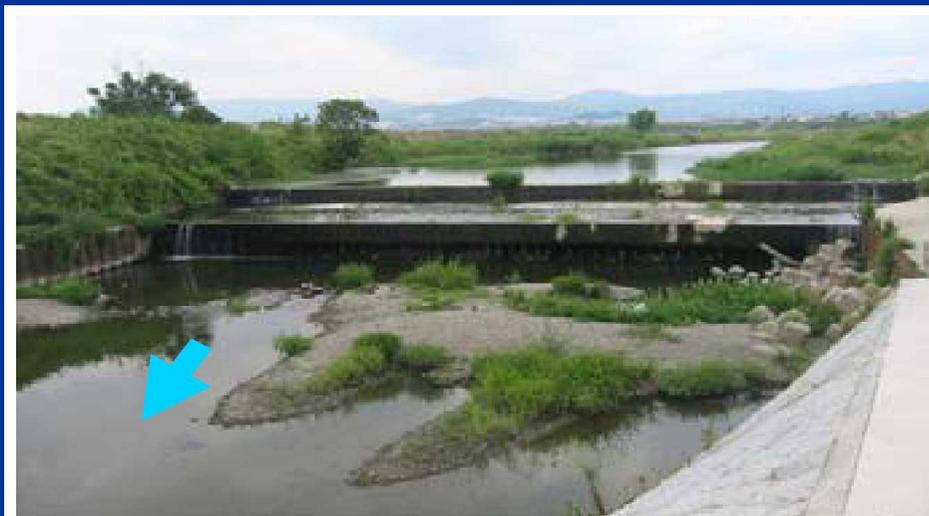
写真 4.2.3-7 縦断方向の河川形状の修復
