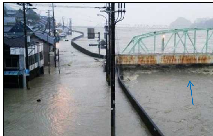
熊野川成川地区 浸水状況
