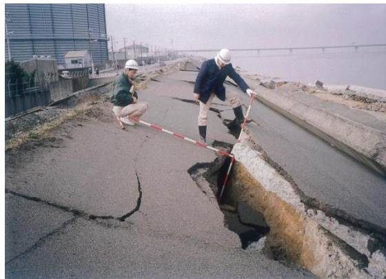
淀川左岸 0.9k 堤防崩壊（天端） 平成7年1月18日
