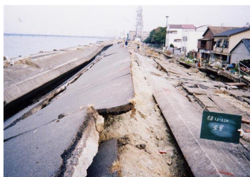
1.2k付近より上流方向を望む。 堤内側法ブロック上半へ堤外側護岸にかけて 著しく陥没、崩壊。
