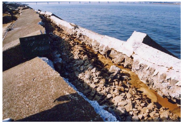
張ブロックの陥没状況
