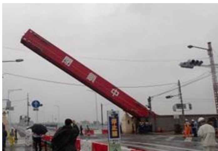
淀川防潮鉄扉（陸閘）の操作状況（平成 30 年台風第 21 号）
