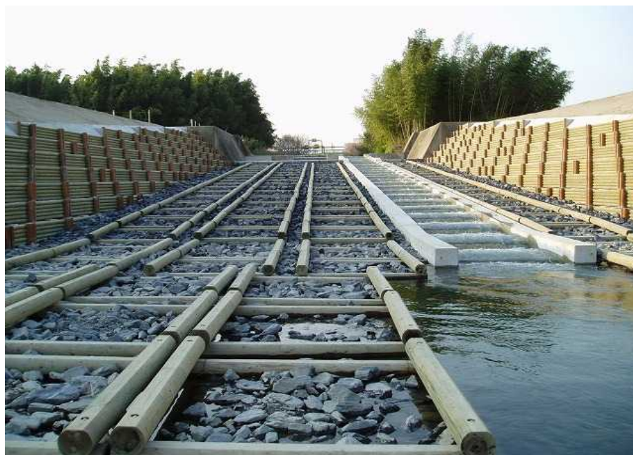
小泉川落差工災害復旧工事
