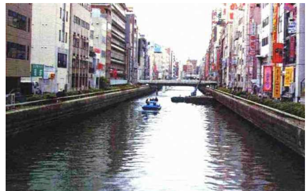
写真-1 整備前の道頓堀川
