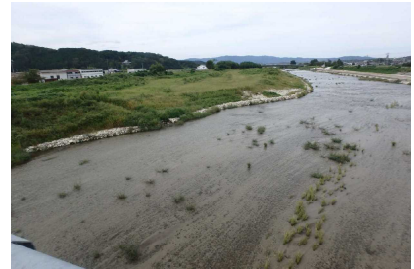
寄せ石の間から植生が生え、良好な生息環境を創出
