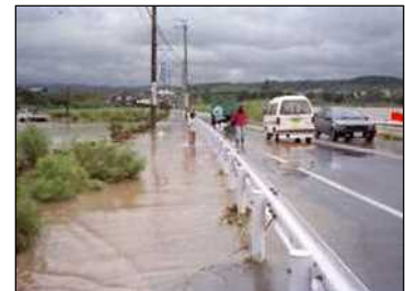
国道422号浸水状況
