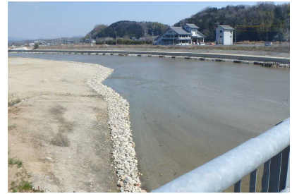
低水路の法尻に寄せ石を設置
