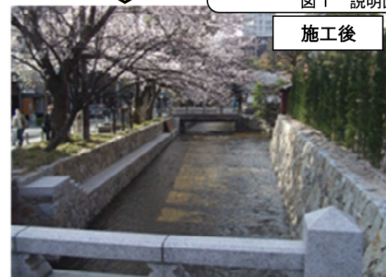
写真 1 高瀬川改修前後
