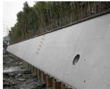
写真4 パネル設置完了
