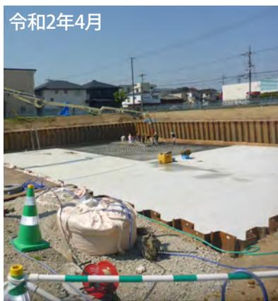
二次掘削作業が完了した後、コンクリートの打設作業を実施。
