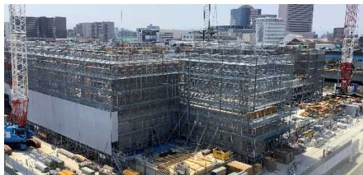
建設状況（令和5年6月） 古川下水ポンプ場
