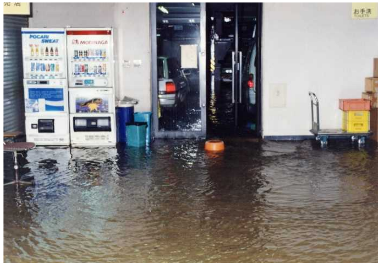
平成6年の浸水被害（市役所の地下が浸水）
