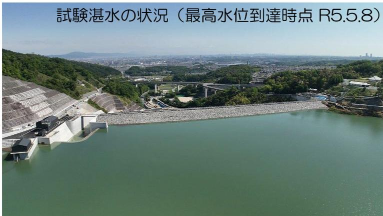
試験湛水の状況（最高水位到達時点 R5.5.8）
