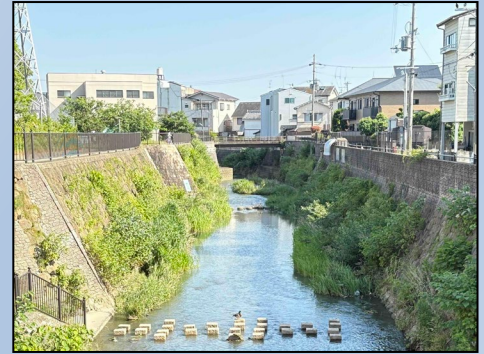
多自然型護岸と滞筋の形成
