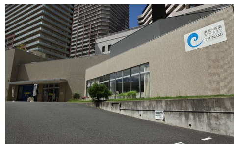
▲津波・高潮ステーション外観
