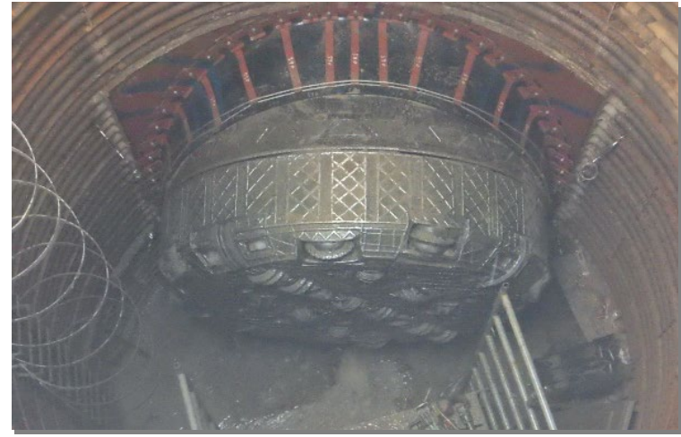
写真-5 立坑に到達した掘進機（左支川推進区間）
