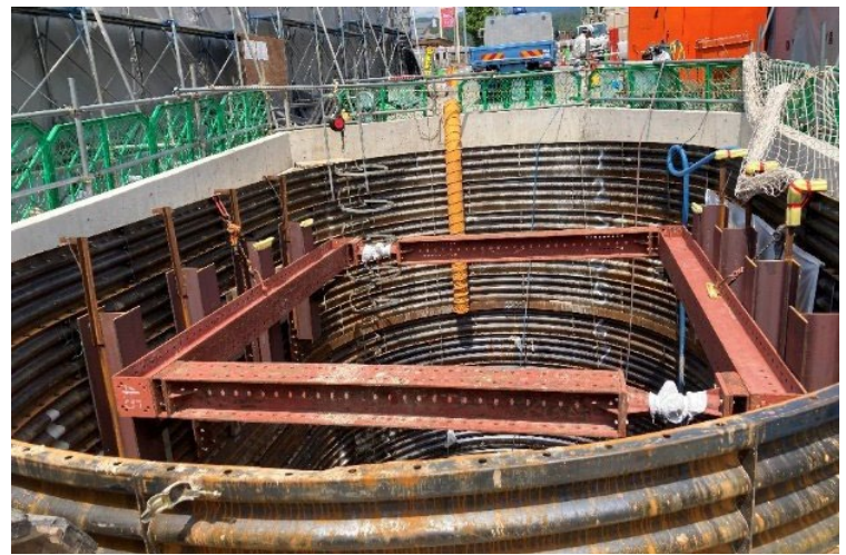
写真-3 立坑築造（左支川接続部）
