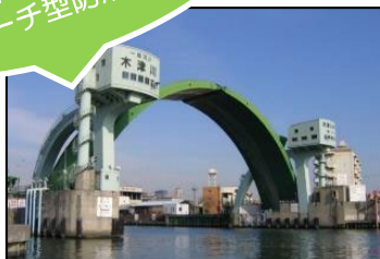
▲現在の木津川水門
