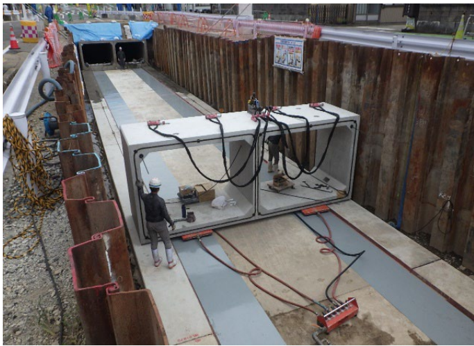
写真-2 2連ボックス設置
