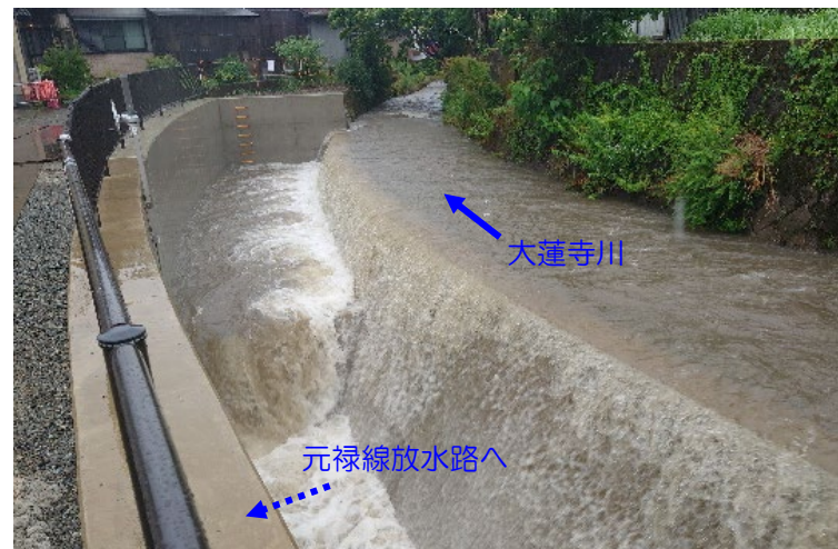
写真-7 左支川分流施設の越水状況（令和6年6月降雨時）
