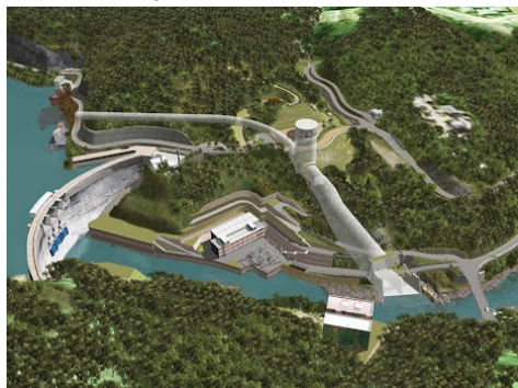
天ヶ瀬ダム再開発事業 トンネル式放流設備
