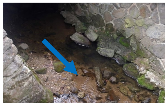
榛原駅周辺の石積み護岸
