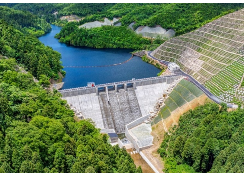
吉野瀬川ダム完成 (全景)
