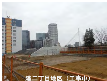
湊二丁目地区（工事中）
