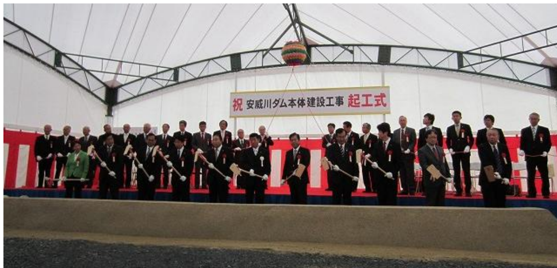
写真 1：起工式（鍬入れの様子）
