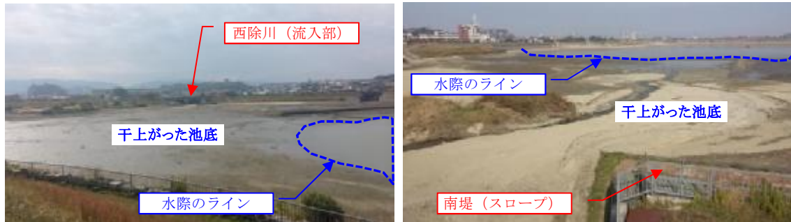
【図 3.2】狭山池ダムにおける池干し実施状況
