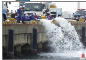
全国から支援を得た排水ポンプ車による排水活動
