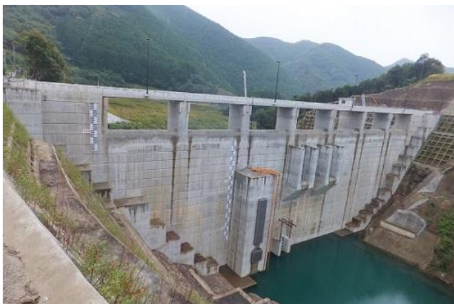
試験湛水開始時の切目川ダムの状況 (平成26年10月20日ダム上流左岸から撮影)
