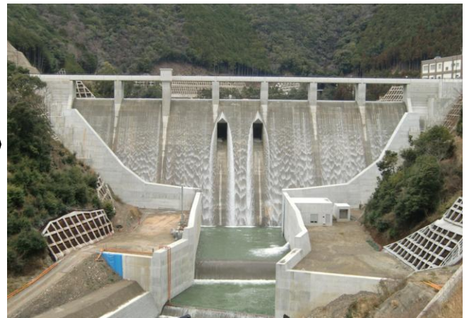
最高水位まで貯水された切目川ダムの状況 (平成27年1月27日 ダム下流から撮影)
