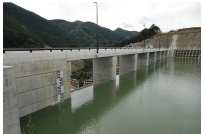
最高水位まで貯水された切目川ダムの状況 (平成27年1月27日ダム上流左岸から撮影)
