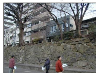
WS実施状況(現地点検)
