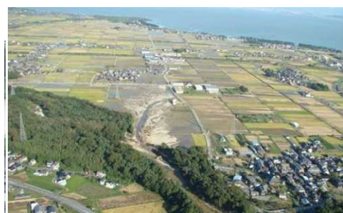
写真-3 破堤箇所の状況（18日）
