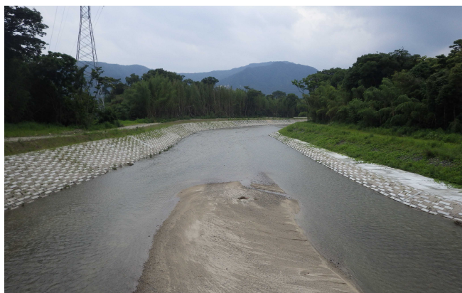
写真-6 工事完成状況（平成 27 年 7 月 2 日起点）
