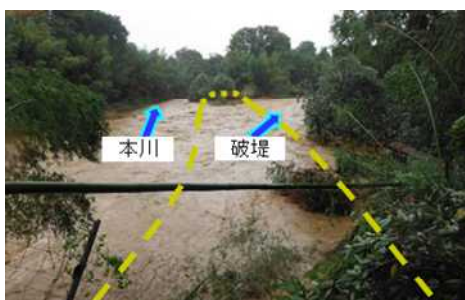
写真-1 破堤箇所の状況（16日6時頃）
