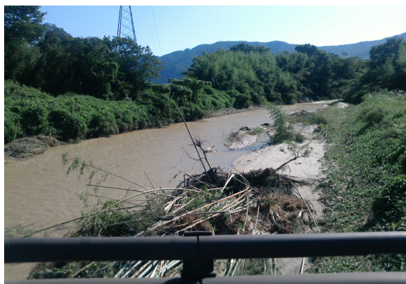
写真-5 被災直後（平成 25 年 9 月 18 日起点）
