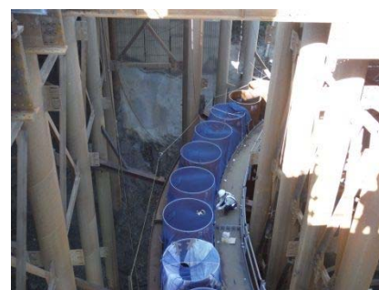
流入部 鋼管矢板施工
