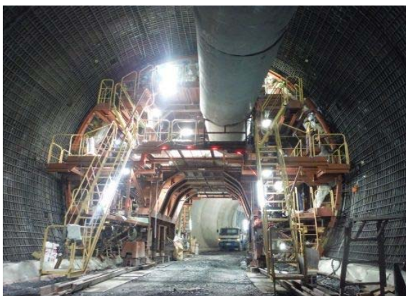
導流部 インバート部分覆工
