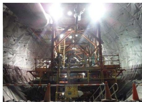
導流部 アーチ部分覆工
