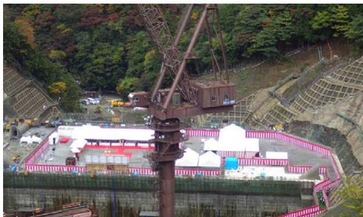
写真-1 定礎式会場全景
