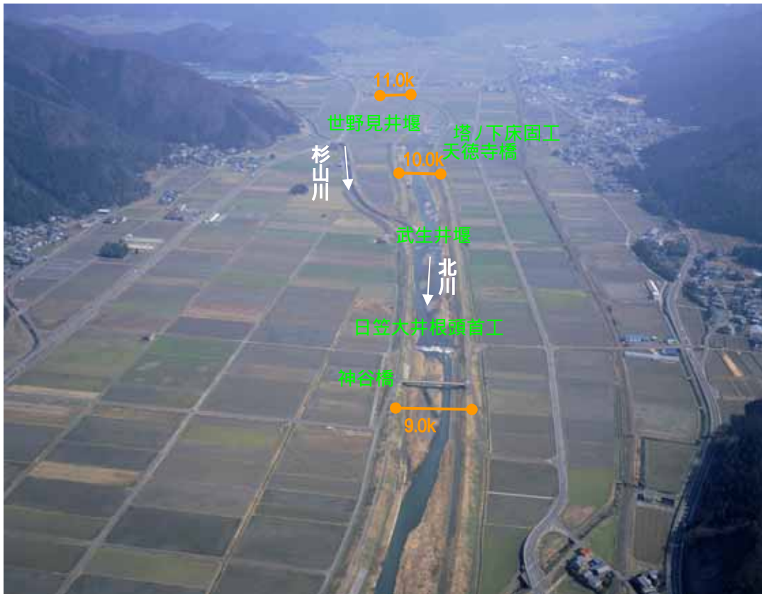
9.0k付近から上流部を望む(平成20年3月撮影)
