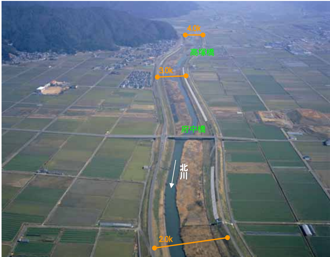
2.0k付近から上流部を望む(平成20年3月撮影)
