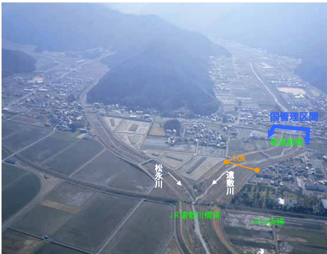
松永川合流部から上流部を望む(平成20年3月撮影)
