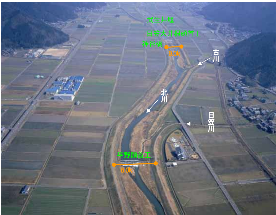
8.0k付近から上流部を望む(平成20年3月撮影)
