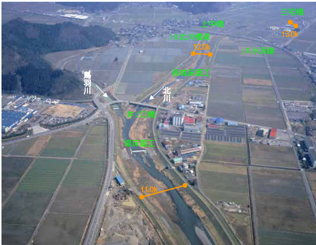
11.0k付近から上流部を望む(平成20年3月撮影)
