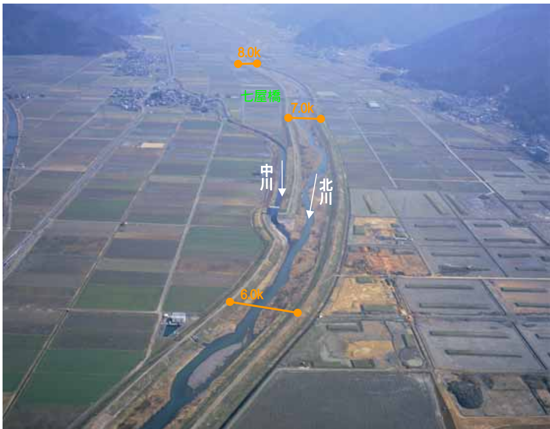
6.0k付近から上流部を望む(平成20年3月撮影)
