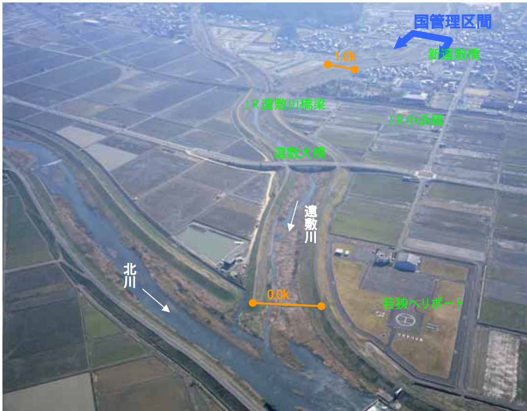
北川合流部から上流部を望む(平成20年3月撮影)
