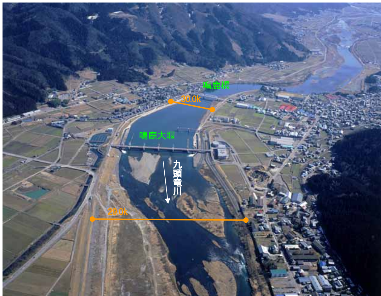
29.0k付近から上流部を望む(平成20年3月撮影)
