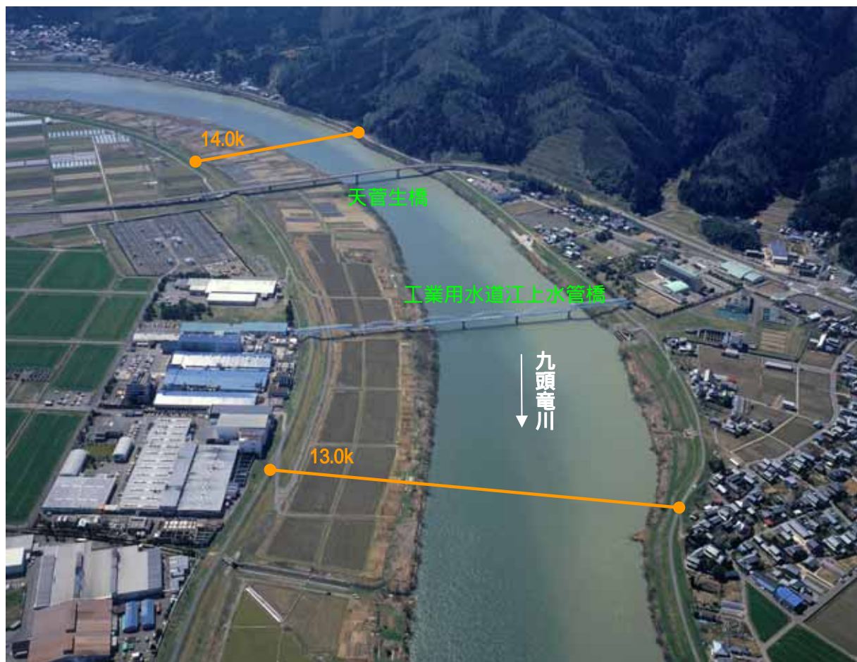
13.0k付近から上流部を望む(平成20年3月撮影)
