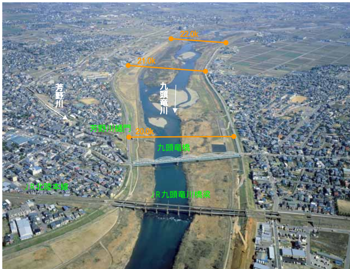
20.0k付近から上流部を望む(平成19年2月撮影)
