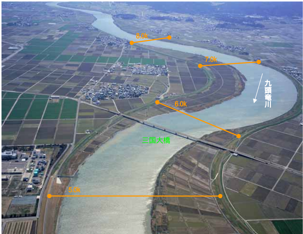
5.0k付近から上流部を望む(平成20年3月撮影)
