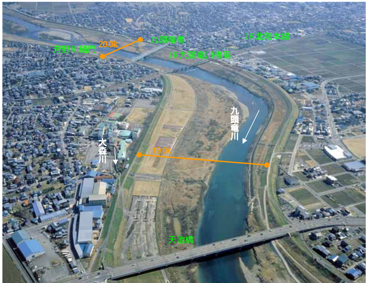
19.0k付近から上流部を望む(平成19年2月撮影)
