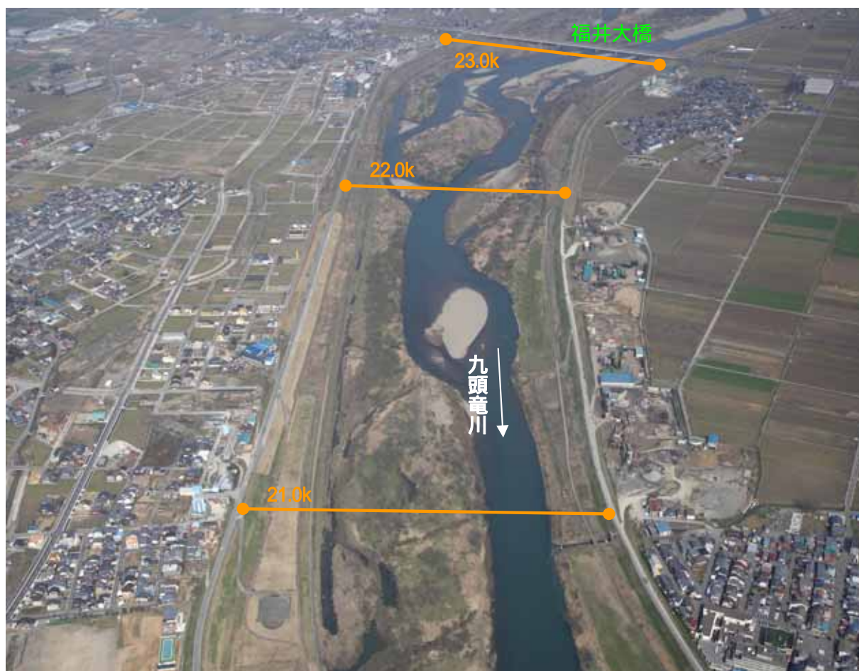
21.0k付近から上流部を望む(平成19年3月撮影)
