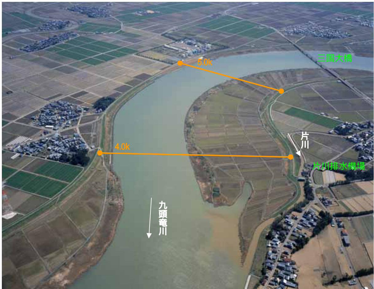
4.0k付近から上流部を望む(平成20年3月撮影)
