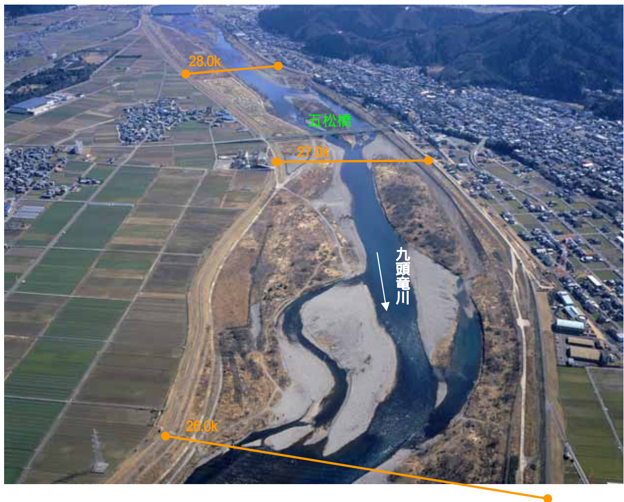
26.0k付近から上流部を望む(平成20年3月撮影)
