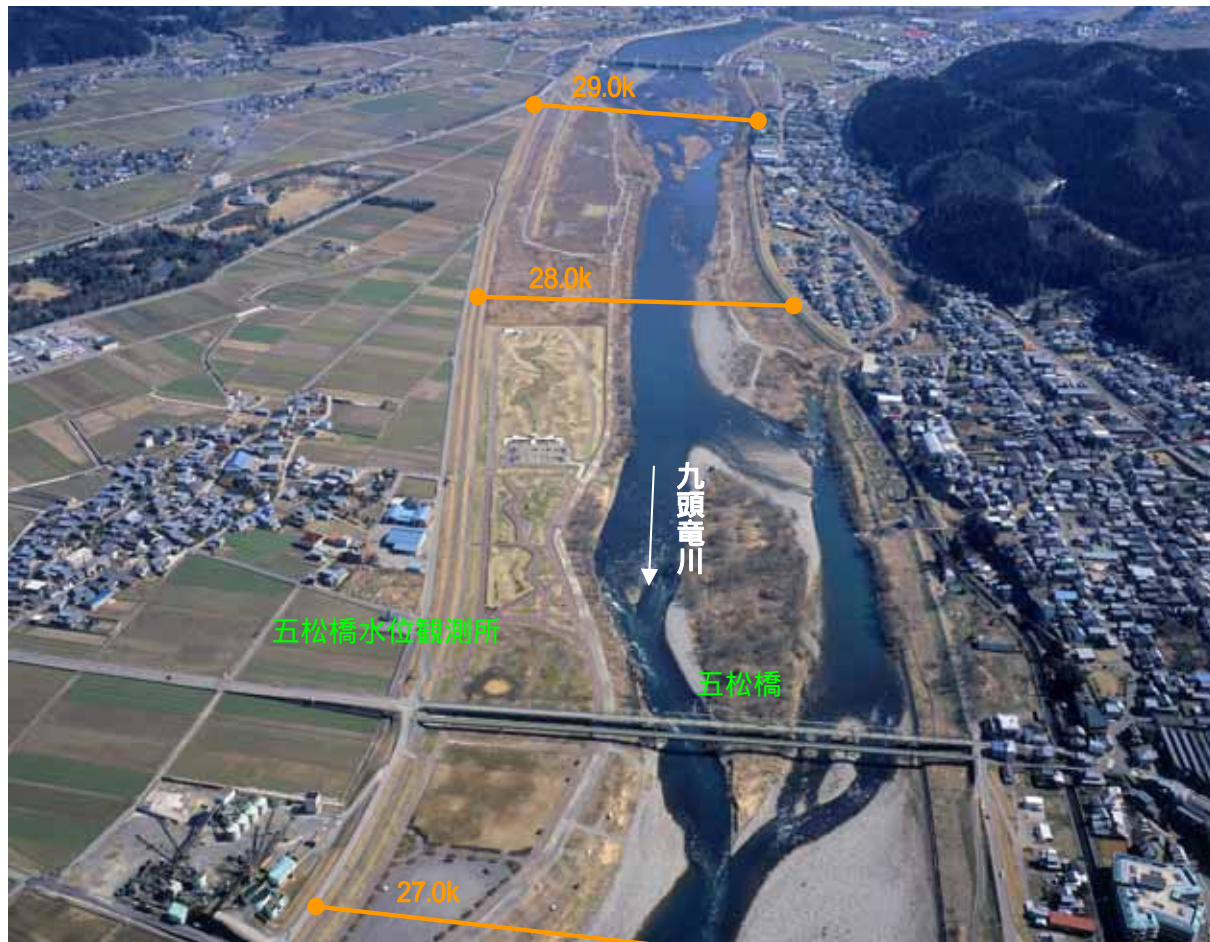
27.0k付近から上流部を望む(平成20年3月撮影)
