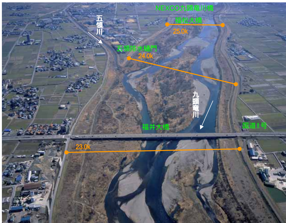
23.0k付近から上流部を望む(平成20年3月撮影)
