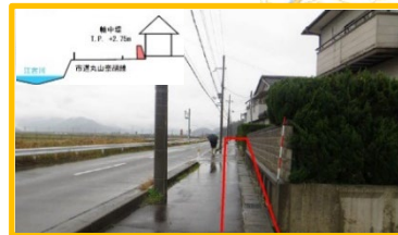
江古川地区の輪中堤整備(福井県)
