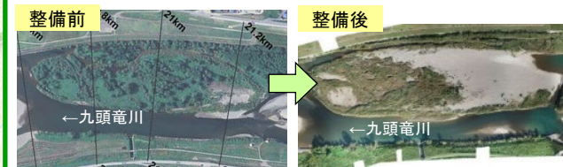
砂礫河原再生状況(森田地区)
