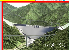
足羽川ダム建設（国）
