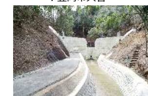
砂防堰堤の設置 (兵庫県 豊岡土木事務所)
