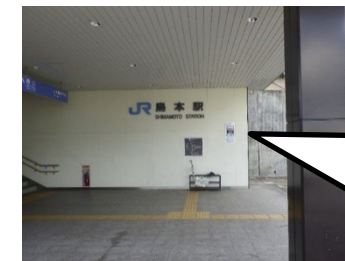
浸水深2.2mJR島本駅東口
