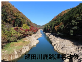
河川改修・維持管理
