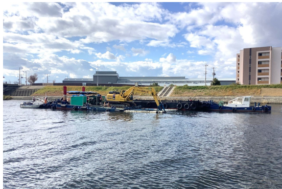
戸ノ内地区河道掘削(国土交通省)
