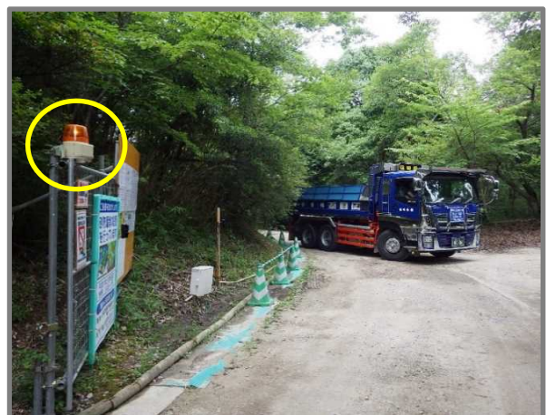
写真-5 車両出入口警報システム設置状況 (左：公園駐車場側、右：索道基地側)
