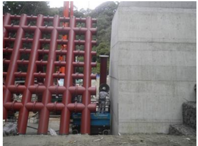
高所作業車によるボルト締め
