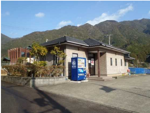
写真-9 避難場所（本工事現場事務所）
