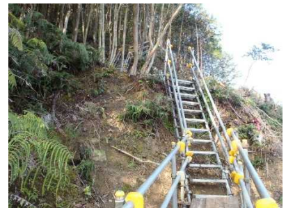
写真-5 設置状況
