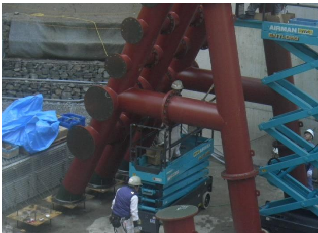
高所作業車によるボルト締め
