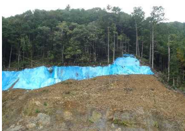
写真-6 着工前状況
