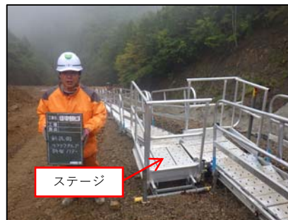
写真-4 盛土箇所の昇降設備
