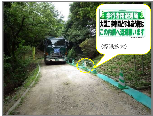
写真-4 退避場設置と工事車両運行状況
