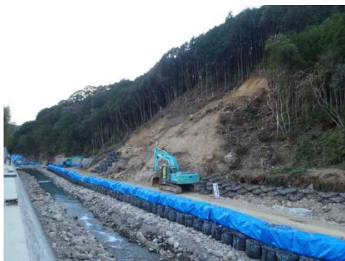
写真-1 施工状況
