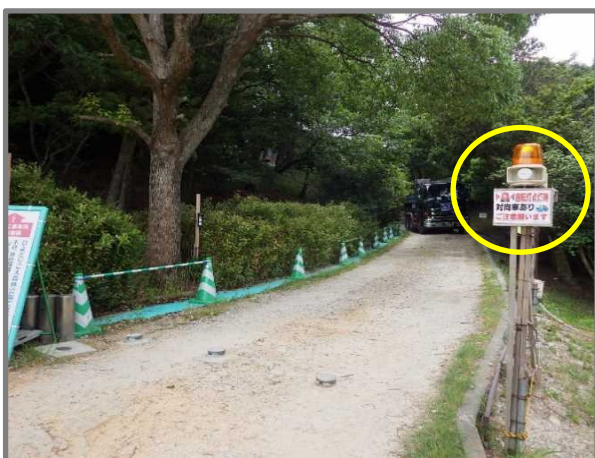
写真-5 車両出入口警報システム設置状況 (左：公園駐車場側、右：索道基地側)
