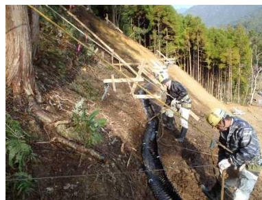
写真-7 ロープ作業
