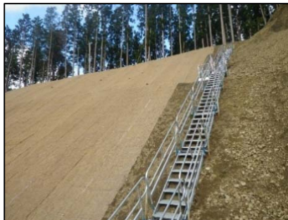
写真-3 掘削箇所の昇降設備
