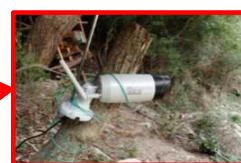
写真2 カメラ カメラは死角の無いよう2台設置。
