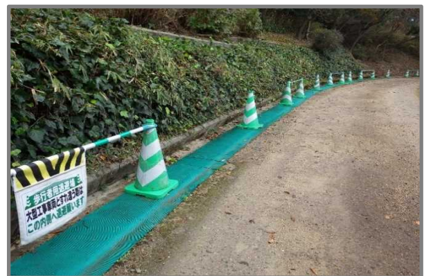
写真-2 歩行者用退避場設置状況
