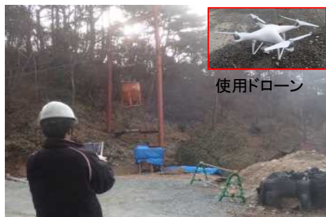
写真8 ドローンによる点検状況
