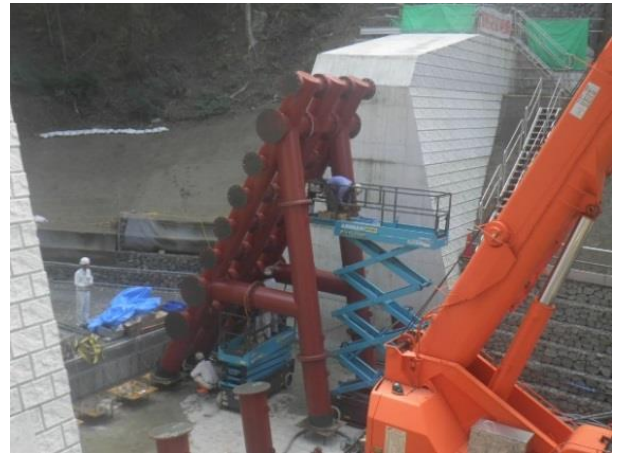
高所作業車によるボルト締め
