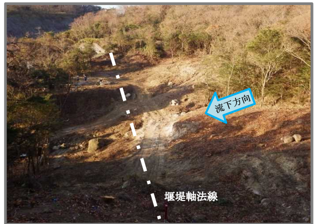
写真-1 着工前(伐採完了後)
