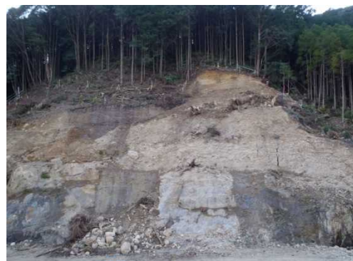
写真-2 法面工予定箇所
