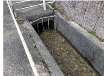
写真-14.排水路土砂堆積状況
