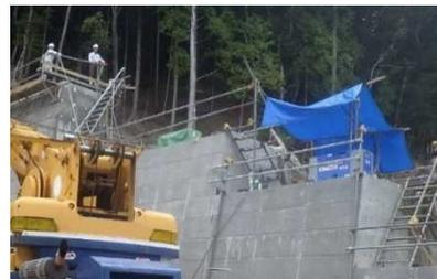
写真-13 工事中の手すりと昇降路
