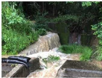
写真-13.谷止め越流状況
