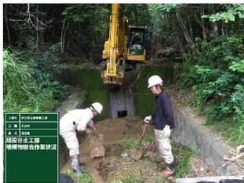
写真-15.堆積土砂撤去状況
