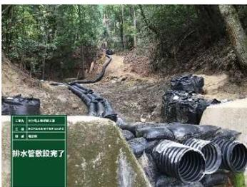
写真-18.排水管布設完了
