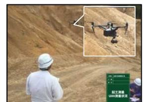
・起工測量及び出来形測量は、当現場のような急峻な場所でも測量作業者が測量機器を担いで移動し作業を繰り返さなければならない。⇨安全な場所から測量可能。
