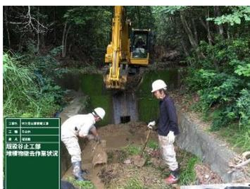
写真-7.堆積土砂撤去状況
