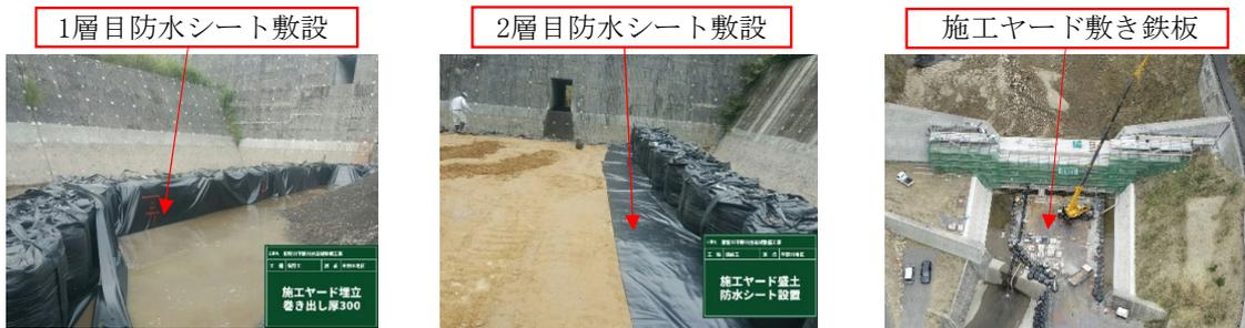
施工ヤードの外周に沿って大型土のうを2段積みで設置する際に防水シートを巻き込み盛土内部への水の浸入及び土砂の流出を阻止。そうすることで、施工ヤードの地盤の軟弱化を防ぎました。
