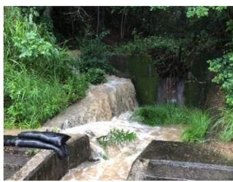
写真-5.谷止め越流状況
