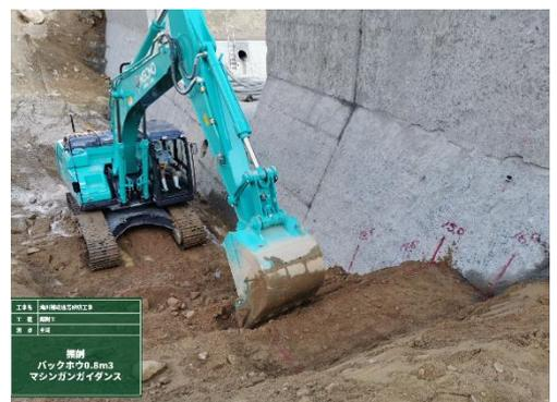
写真6 マシンガイダンス重機
