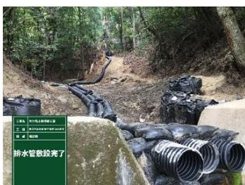
写真-10.排水管布設完了
