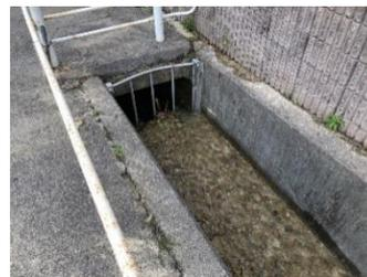
写真-6.排水路土砂堆積状況
