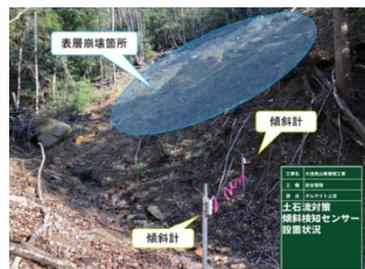
写真-22.傾斜計設置状況
