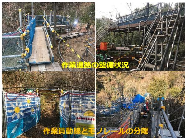
■ 写真-8 作業通路の整備と作業員動線とモノレールの分離状況
