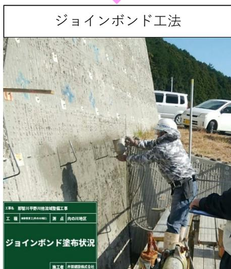
ジョインボンド工法では、チップングハンマーによる激しい振動や騒音は飛躍的に抑えられ、作業員が直接粉塵を吸い込むことがなくなり、労働災害による健康リスク低減につながりました。
