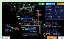
吹付機での各種設定状況
