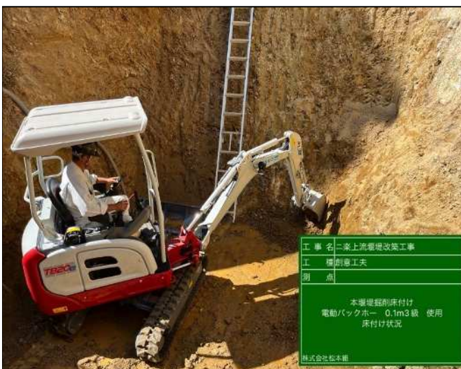
電動バックホウ使用状況
