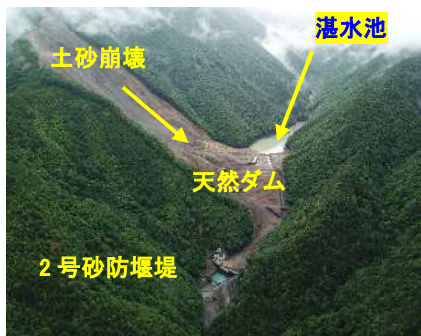
写真 1. 河道閉塞 (下流より)
