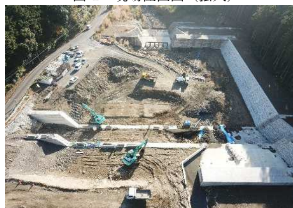
写真-2 施工状況(空撮)【床固工・護岸工】
