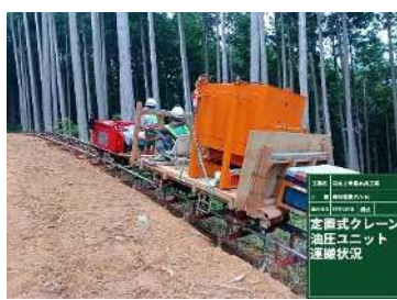
写真-6 油圧ユニット運搬状況
