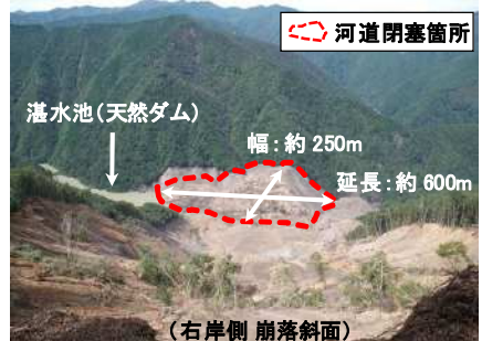
写真-1 河道閉塞状況
