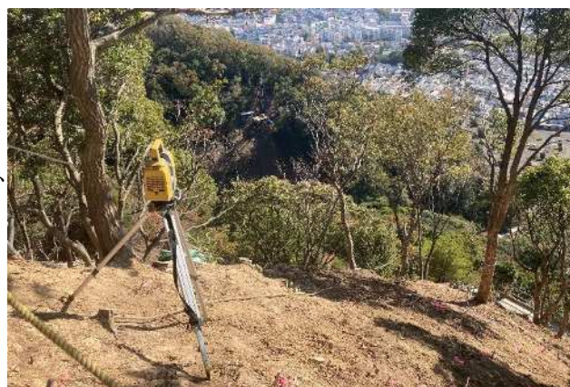
■写真-5 3D測量の実施状況
