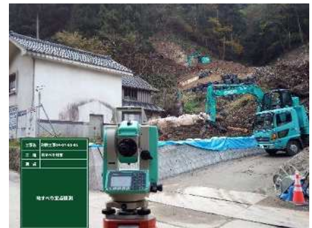
写真-7 機器設置
