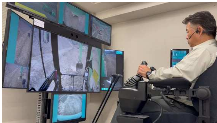
写真-4 無人化施工実施状況
