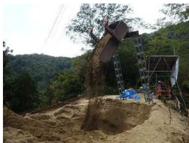
土砂バケツ 自動転倒装置 作業状況
