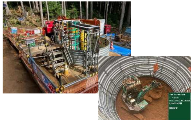
写真-1・2 施工状況
