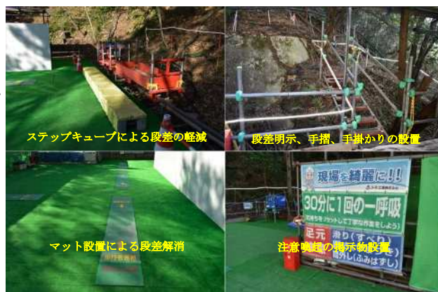
■写真-7 段差解消等の転倒対策実施状況
