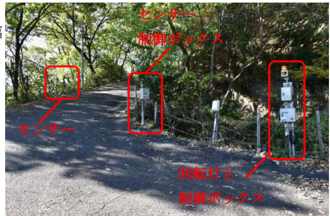
■写真-3 カークルの設置状況
