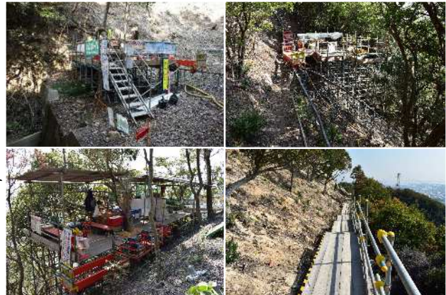
■写真-9 仮設通路と仮設ステージの設置状況
