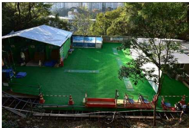
■写真-6 大型ステージの設置状況
