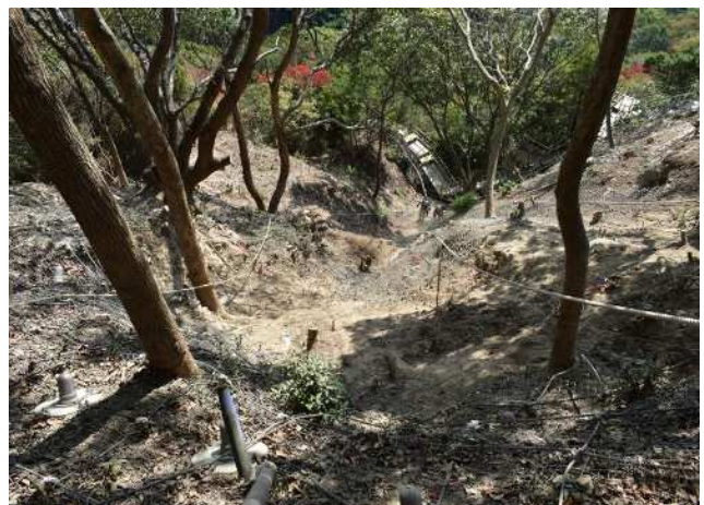
■ 写真-2 東側斜面：斜面北側より撮影
