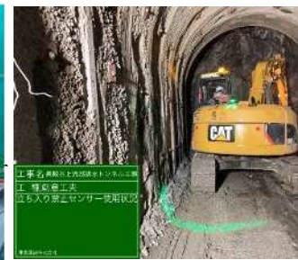
写真6. 重機作業半径
