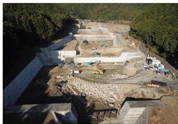
写真-1 施工状況(空撮)【遊砂地全景】
