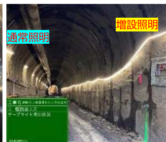
写真8. 坑内照明増設
