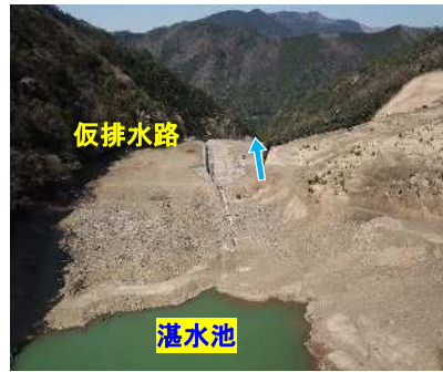
写真 2. 河道閉塞 (上流より)
