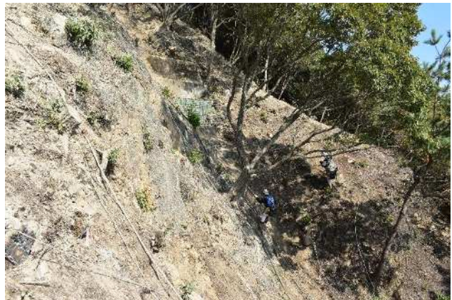
■写真-10 ラス金網の設置による落石対策状況
