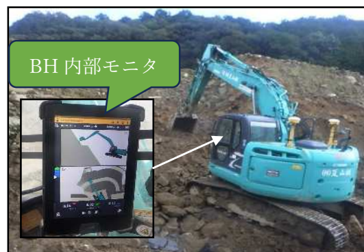
写真-6 バックホウによる掘削状況
