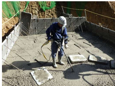
専用アプリ内蔵スマホ・バッテリーを装 着してのコンクリート打設
