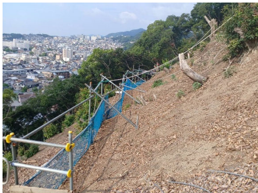
図-11 中腹部単管柵設置
