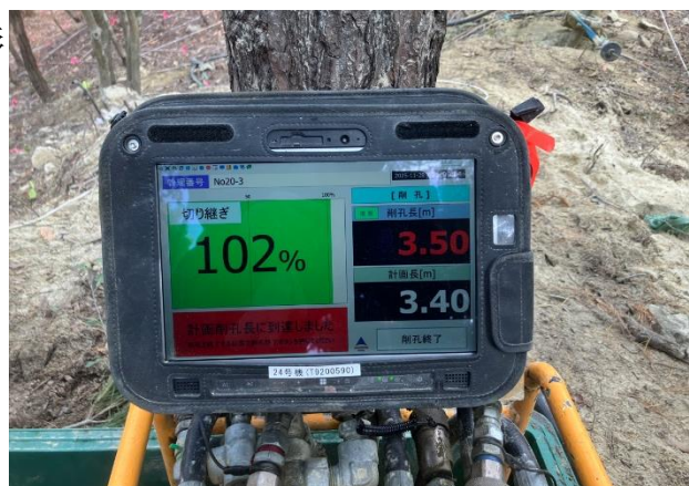
■写真-6 ICT削孔管理システムの活用状況
