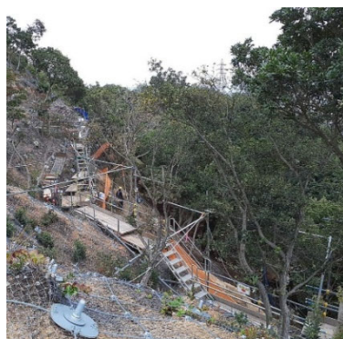
写真-8 斜面上部安全通路
