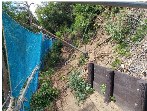
図-12 最下部単管柵設置
