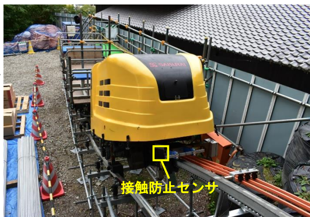
■写真-7 接触防止センサ付き 電動モノレールの活用状況
