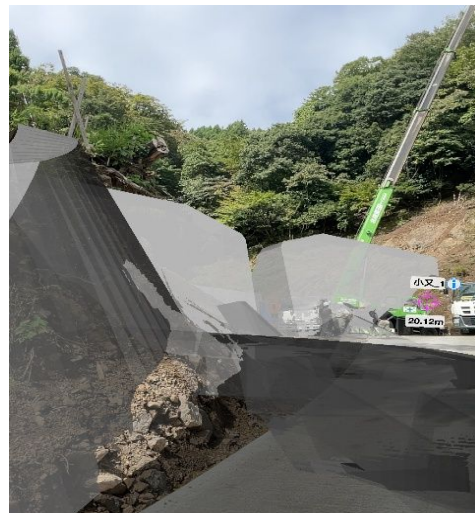
図-9 LRTK Phone (iPad) による 完成構造物のAR表示
