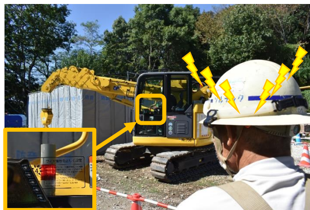
■写真-5 重機接近検知システムの活用状況
