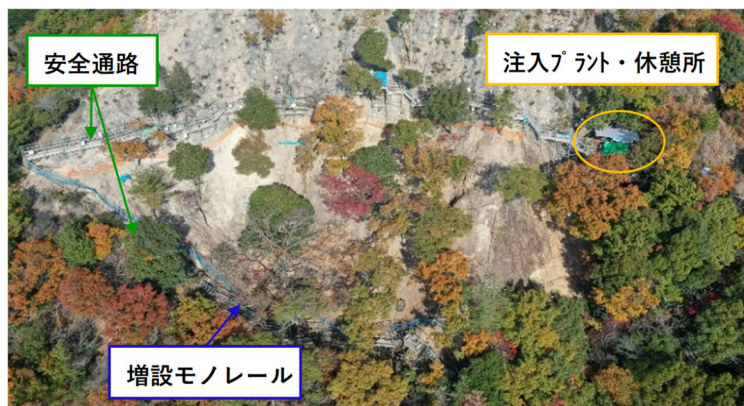
写真-3 安全通路、増設モノレール設置状況
