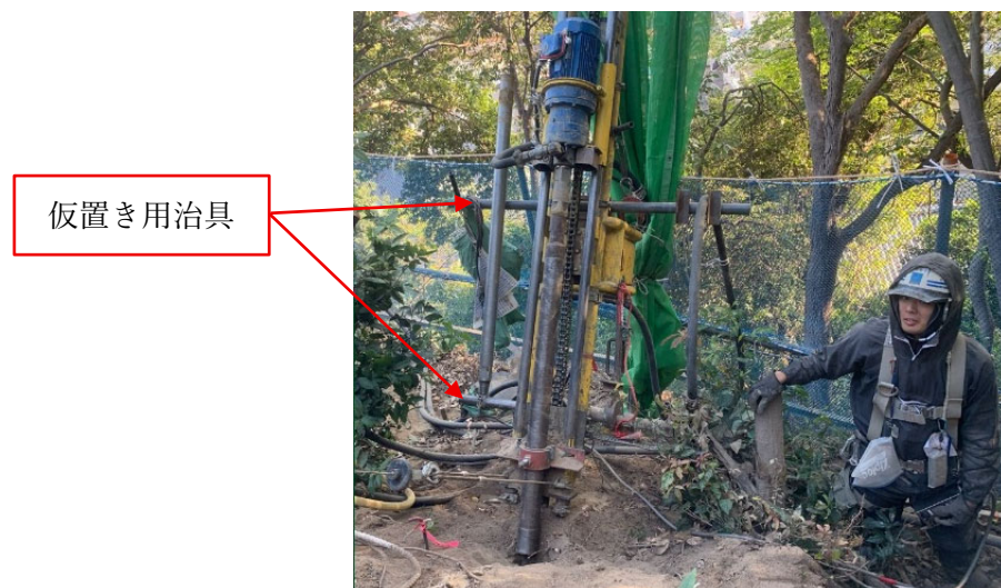
図-5 ケーシング・ロッド仮置き用治具設置
