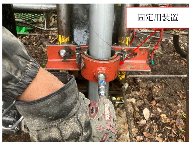
図-3 固定用装置の施工 (ボルト固定による脱着作業)
