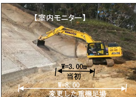
写真-3 掘削状況(MC)
