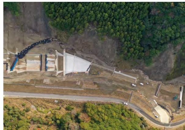
写真-2 施工状況 空撮【流路】
