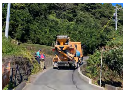
写真10 農道を使用しての運搬
