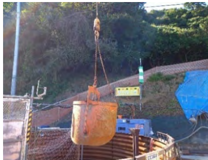
写真6 補助吊具の使用
