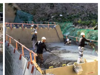
【写-15 FRP製単管による転落防止柵】
