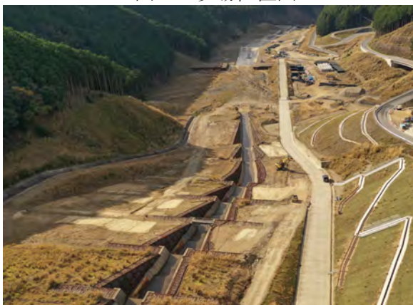
写真-1 施工状況 空撮【落差工】
