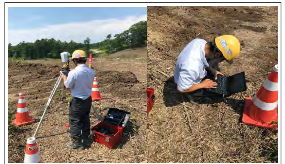
写真-2 現地基地局GNSS設置
