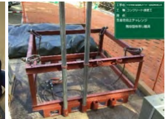
【写-12 運送業者と打合せ】 【写-13 専用吊り枠】
