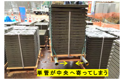
【写-11 従来の吊り上げ】
