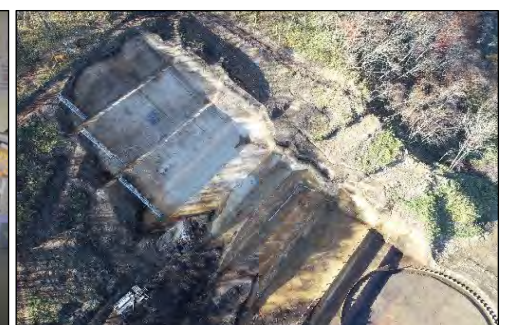
写真-5 掘削完了(MC)
