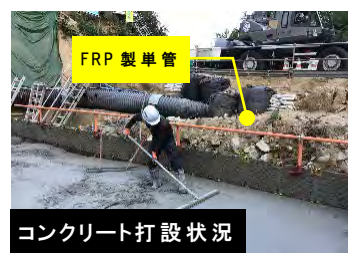
【写-15 FRP製単管による転落防止柵】
