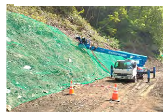
落石防止ネットの施工
