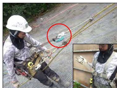
写真-9 斜面用フルハーネス使用例
