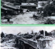
木々の山となった小国橋
