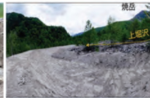
土石流減勢工
