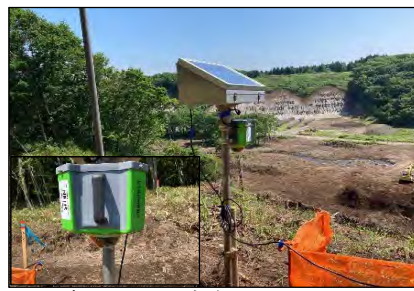
写真-7 現場定点カメラ設置
