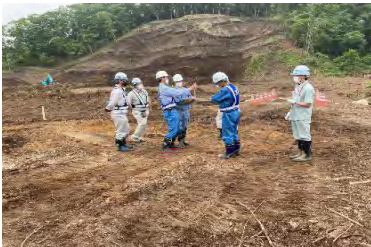
写真-12 労基合同パトロール
