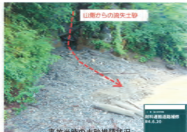
事故当時の土砂堆積状況
