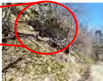
オーバーハングの状況
