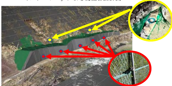
変位測定箇所(補強土壁：プリズム、地山：ノンプリズム)
