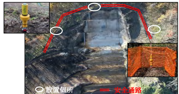
写真-9 スーパーサッチャー設置
