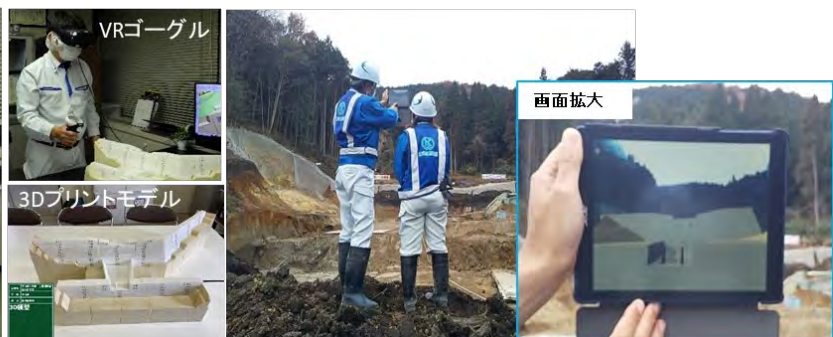
ARを利用した現場打合せ
