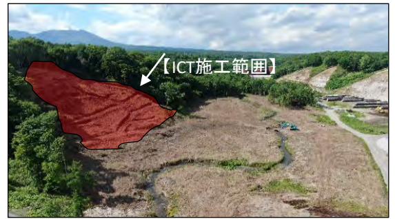
写真-1 掘削箇所(ICT掘削箇所(ICT))
