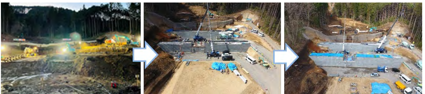
写真-1 施工状況
