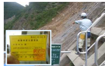
【斜面判定士 現地確認】
