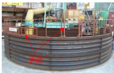
墜落転落防止対策 手摺の設置
