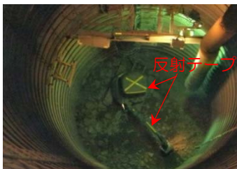
クレーンオペへの視認性向上 反射テープ設置
