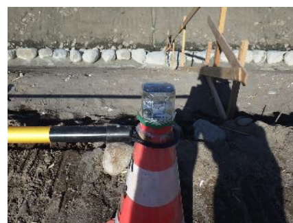
写真-4 点滅器設置
