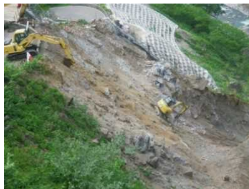
【斜面掘削状況(無人化掘削)】
