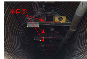
飛来落下防止対策 半月盤の設置
