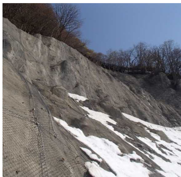
写真-1 着工前の現場法面
