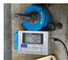
写真-15 引張試験実施状況
