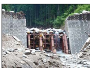
被災直後：鋼製スリット部
