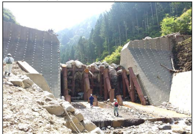
被災直後：堰堤下流側状況
