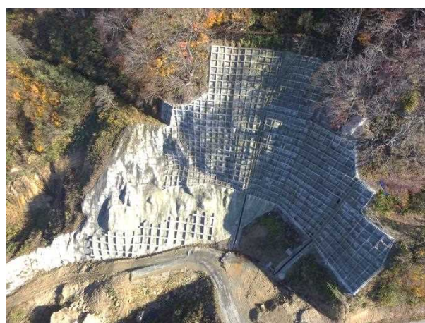
写真-15 完成写真(ドローンによる撮影)
