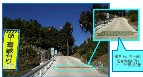
写真-3 架空線対策の状況
