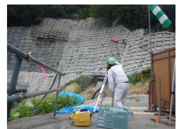
写真-11 地山の定点観測実施状況
