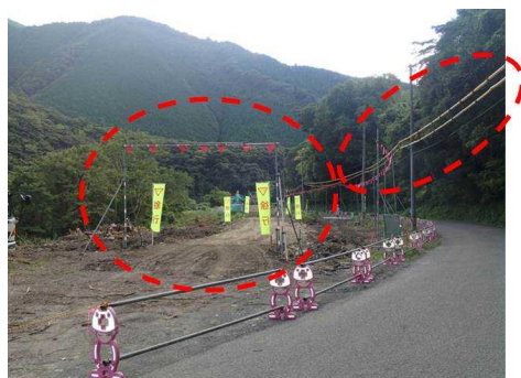
写真-3 架空線対策の状況
