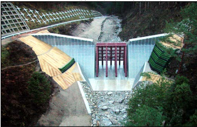
被災直後：鋼製スリット部
