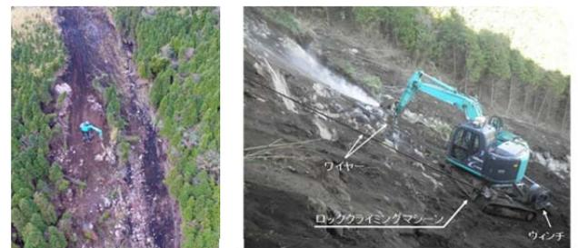
写真-14 ロッククライミングマシンの作業状況
