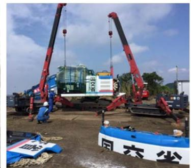
写真-9 頭部での重機組立状況
