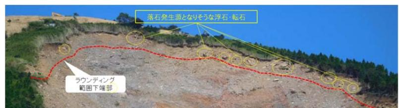
写真-12 ラウンディング施工前の斜面状況と除去範囲
