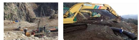
写真-16 有人施工による地質調査と排水施設整備
