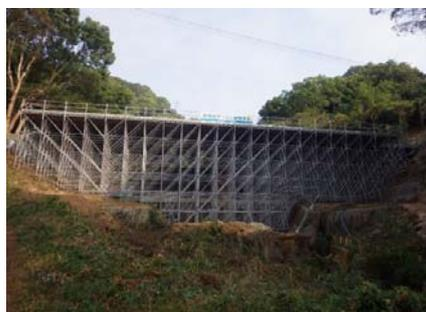
写真-14 仮栈橋設置状況
