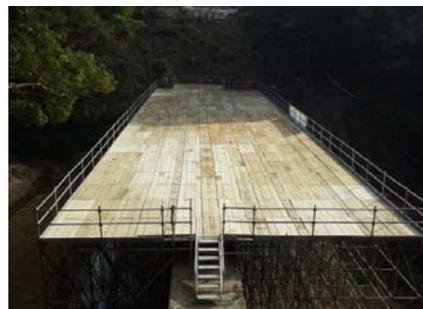
写真-13 仮栈橋設置状況
