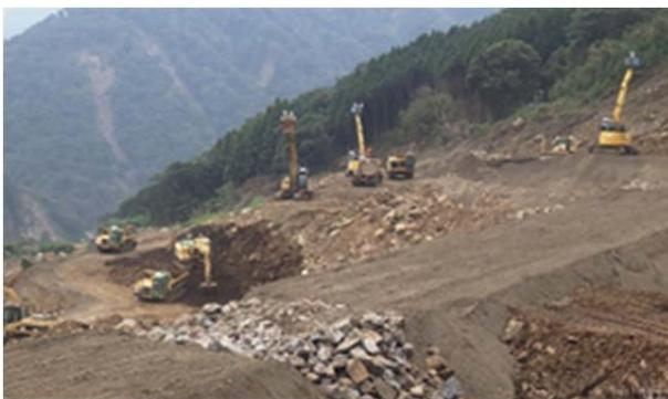
写真-3 崩壊地内で稼働する無人化施工機械
