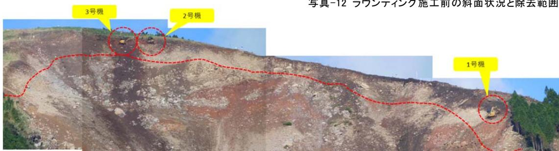
写真-13 3台の高所法面掘削機によるラウンディング施工状況
