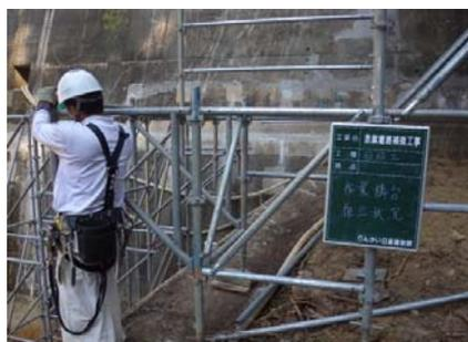
写真-12 仮栈橋組立状況
