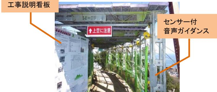
写真-6 センサー式音声ガイダンス
