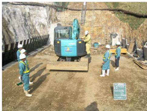
写真6. センサー作動範囲の調整及び確認状況
