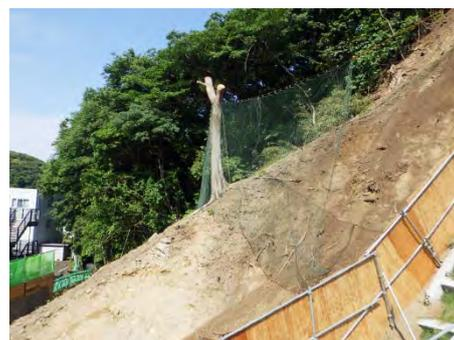
切土作業時には、切り崩した土砂が下部へと落下して行く過程で速度を増し、飛び石が仮設防護柵を越える可能性が考えられた為、法面中段に減勢ネットを張り、落石の速度を緩める事で安全に土砂の切落としを完了しました。
