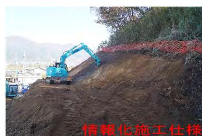
3D-MG (マシンがGPS) 法面整形状況
