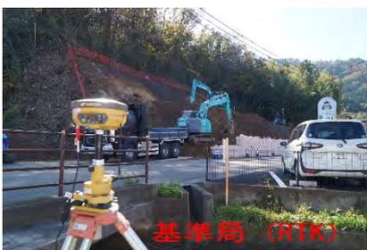
基準点上に設置、マシンがGPSへ位置情報の送信
